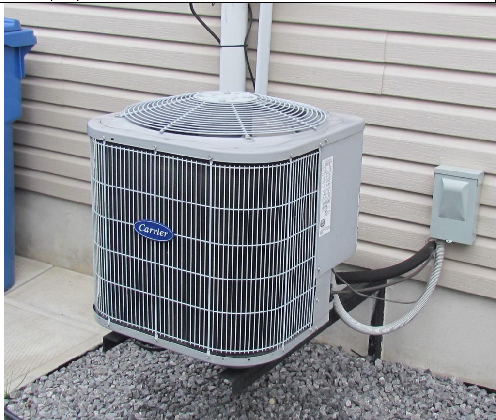
Thermopompe - climatiseur
