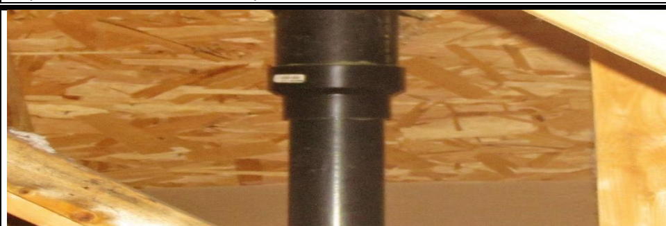
Tuyauterie d'évacuation et tuyau d'évent en ABS
